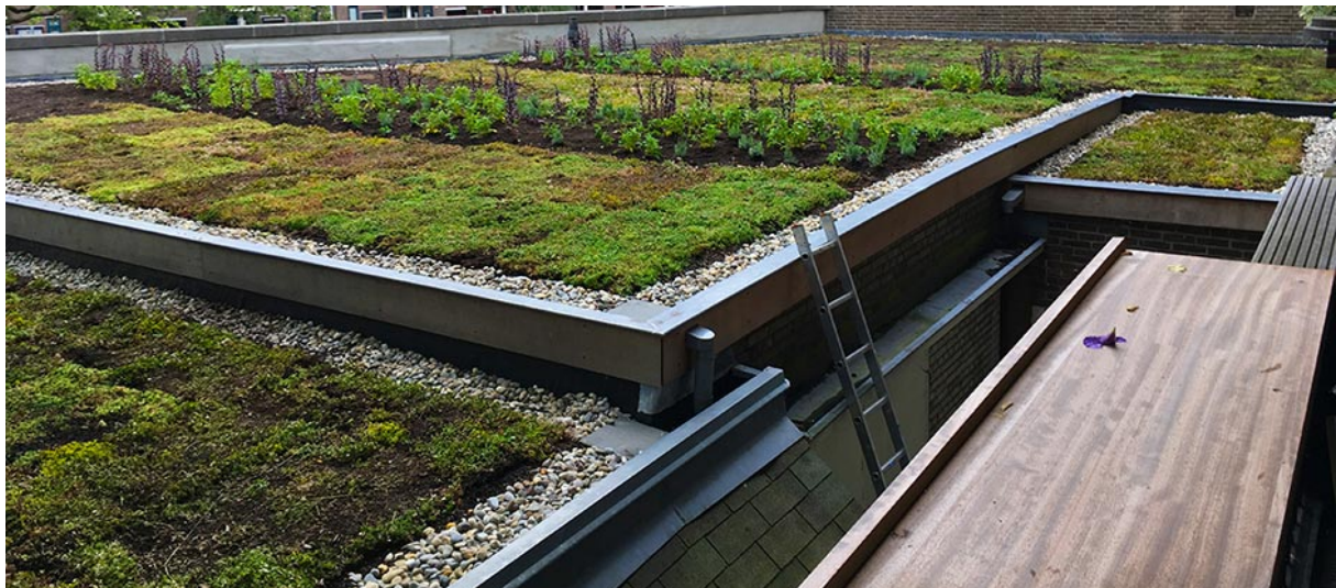
Alklima B.V. op het bedrijventerrein heeft onlangs een duurzame gevel toegevoegd aan hun pand. De begroeiing is toegevoegd op het bijgebouw en geeft niet alleen een prachtige uitstraling, ook draagt het bij aan de verhoging van biodiversiteit. Om de groene daken en gevels op bedrijventerrein Hoogendijk te kunnen aanleggen, kan er contact worden opgenomen met Arie Hartkoorn. Hij legt daktuinen aan om zo een gebied te kunnen vergroenen en een bijdrage te leveren aan een verbeterde samenleving. Het bedrijf zit gevestigd in Alblasterdam en kan bereikt worden via: info@ahdaktuinadvies.nl
